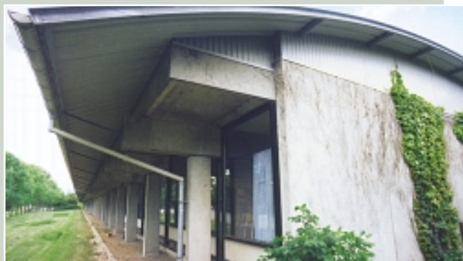
Facadebeklædning i forbildelse med renovering af Kajerød skole ved Birkerød.
