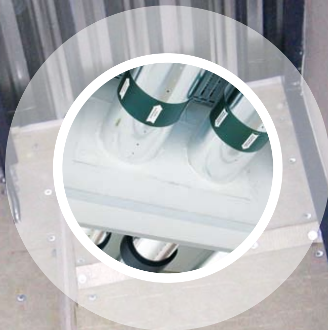
Brandlukning af installationsgennemføringer med brandplade.
